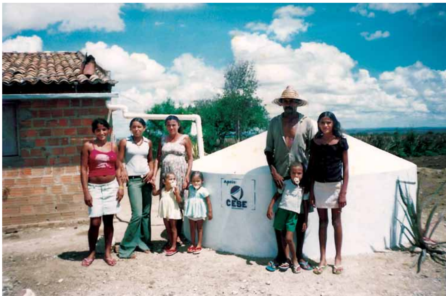
Cisternas de placas ferrocimento. Gentio do Ouro – BA
